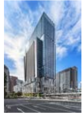
建物外観（JPタワー大阪） イメージ
