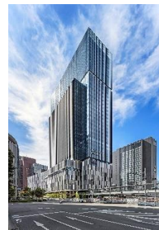
建物外観（JPタワー大阪） イメージ
