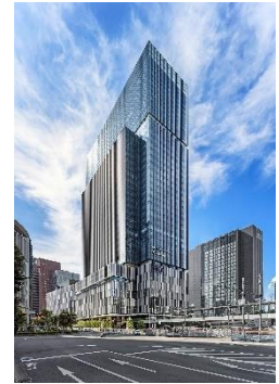
建物外観（JPタワー大阪） イメージ
