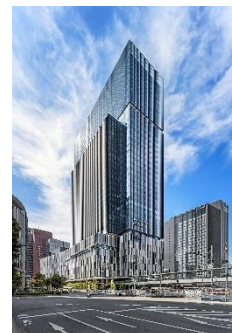
建物外観（JPタワー大阪） イメージ
